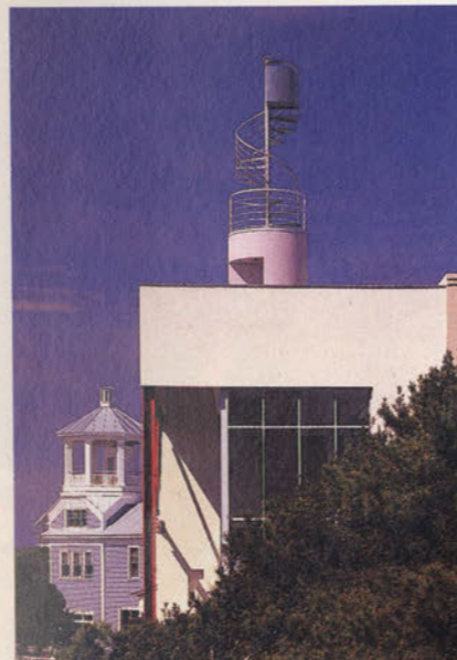
Die neue Stadtkrone von Seaside: eine Spindeltreppe aus Edelstahl
